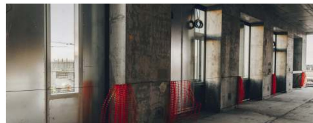
Klæðning Fyrstu hlutar útveggjaklæðningar kommir upp.
