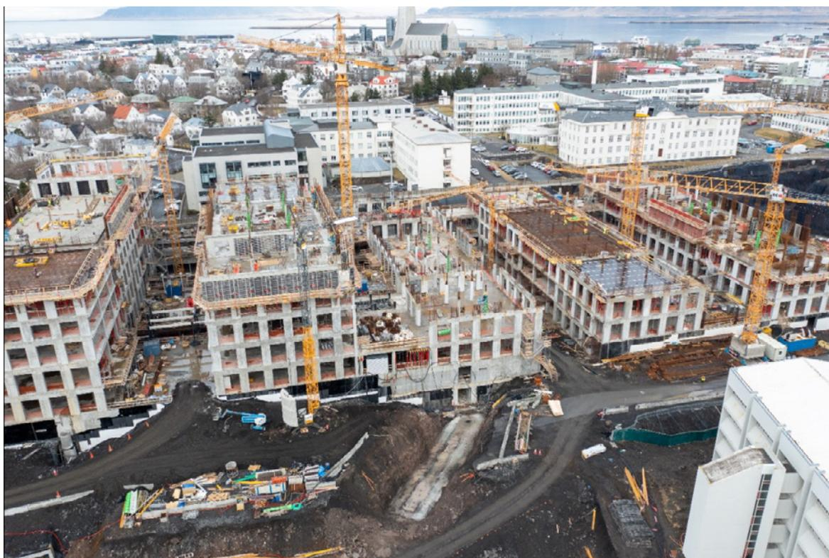
Yfirlitsmynd af uppsteypu nýs meðferðarkjarna. Hér má einnig sjá undirbúningsvinnu fyrir uppsteypu á tengigangi milli meðferðarkjarna og rannsóknarhúss
