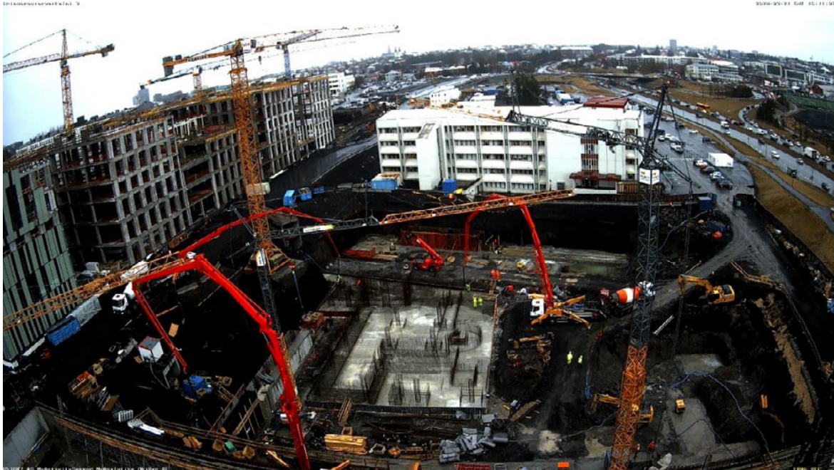
Ein stærsta plata sem steypst hefur verið á svæði NLSH um 1000 m 3 af steypu
