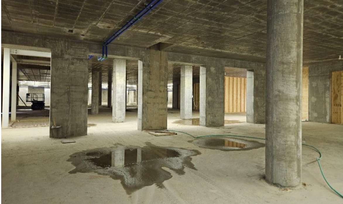
Frágangur eftir uppsteypu og uppsetningu vinnulagna
