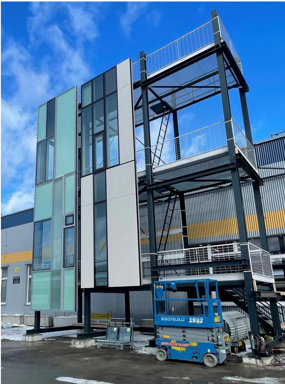
Mynd 1 - Prufuveggur meðferðarkjarna - vinstra megin er sá hluti sem verður á efri hæðum - hægra megin sá hluti sem verður á neðri hæðum
